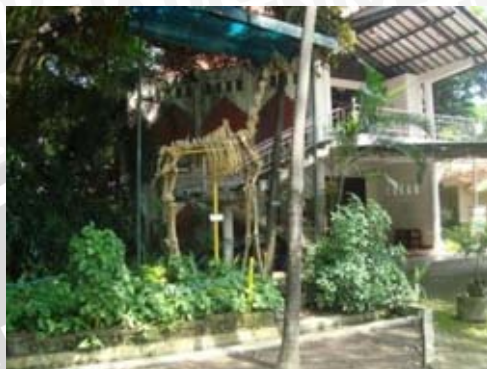
Gambar 4.9 Bangunan eksisting perpustakaan dan auditorium
