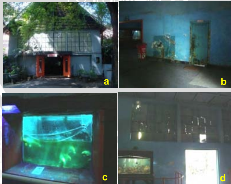
(a). Tampak depan bangunan, (b). Dinding bagian dalam, (c). Kondisi kaca pecah, (d). Penutup dinding.
