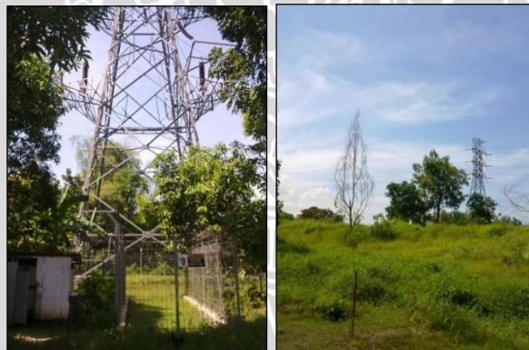
Gambar 4.12 Kondisi Eksisting Jaringan Listrik
