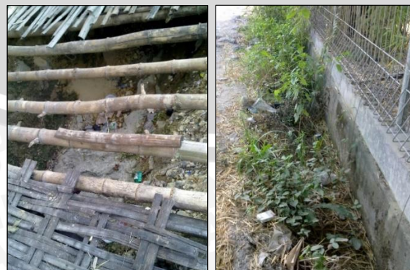
Gambar 4.13 Kondisi Eksisting Drainase Alami
