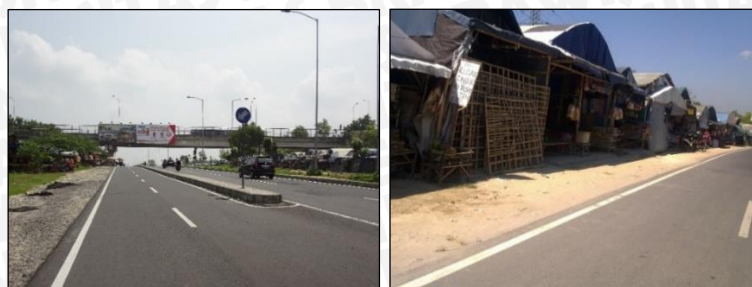
Gambar 4.4 Kondisi Eksisting Sirkulasi
