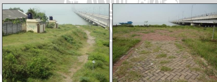
Gambar 4.6 Kondisi Eksisting Taman
