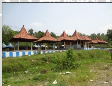
Gambar 4.10 Kondisi Eksisting Fasilitas Beristirahat
