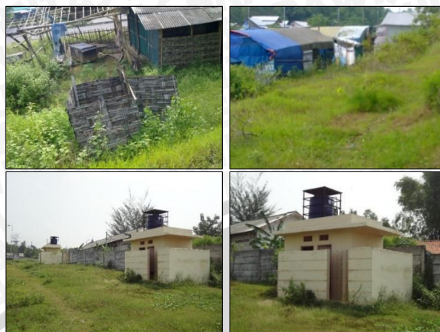
Gambar 4.9 Kondisi Eksisting Toilet
