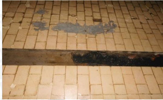
Gambar 4.7 Kondisi Saluran Air Ruang Produksi
