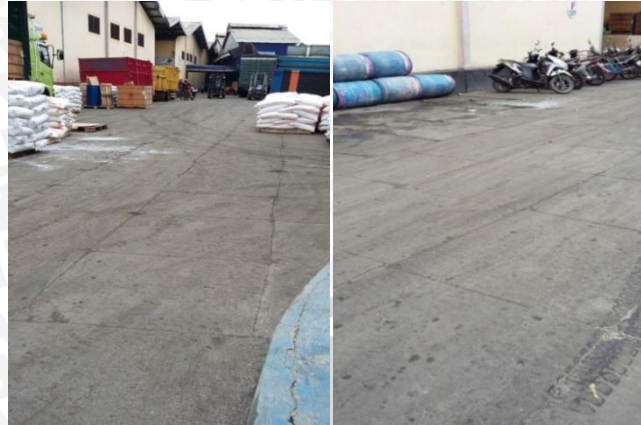
Gambar 4.3 Kondisi Bagian Luar Pabrik
