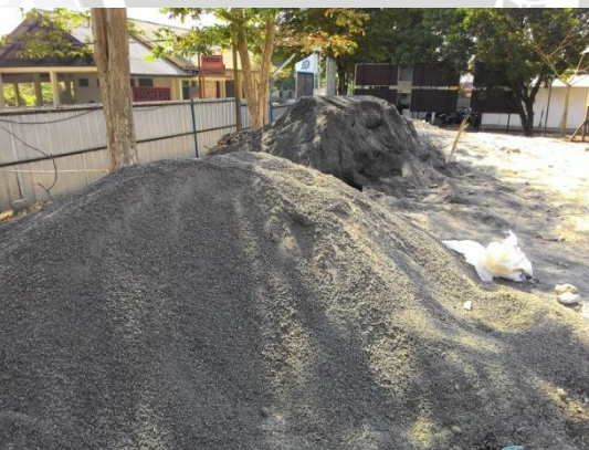
Stockyard pasir dan agregat
