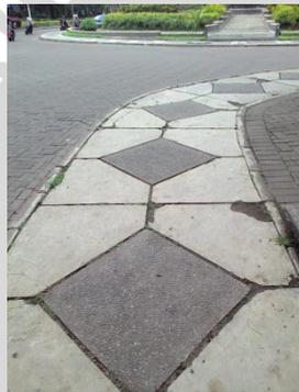
Perkerasan pada jalur pejalan kaki di jalur bundaran menggunakan perkerasan kombinasi concrete dengan batu ampyang
