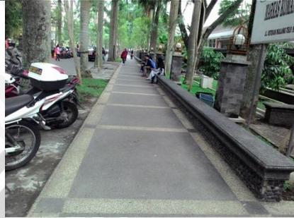
Perkerasan menggunakan perkerasan batu ampyang
