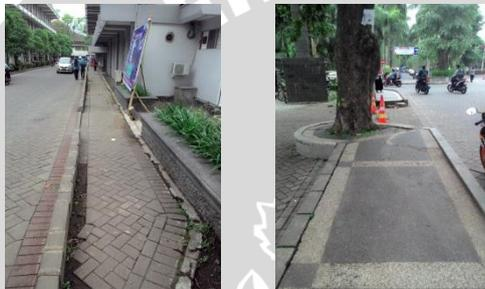
Terdapat dua jenis perkerasan pada jalur ini, yaitu perkerasan batu ampyang dan perkerasaan paving.
