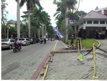
Perkerasan jalur pejalan kaki menggunakan perkerasan batu ampyang
