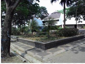
Perkerasan jalur pejalan kaki menggunakan perkerasan berupa batu ampyang dengan pola persegi.
