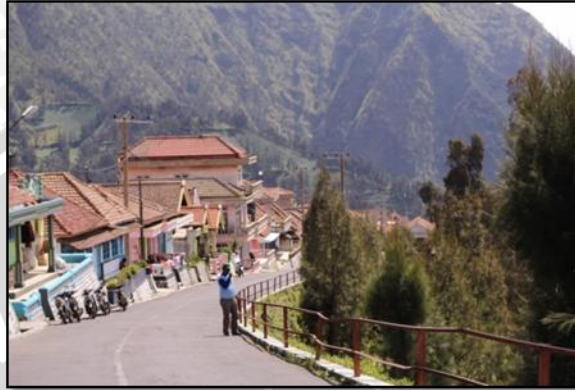
Gambar 4.6 Foto Perkerasan Jalan Aspal di Desa Ngadisari
