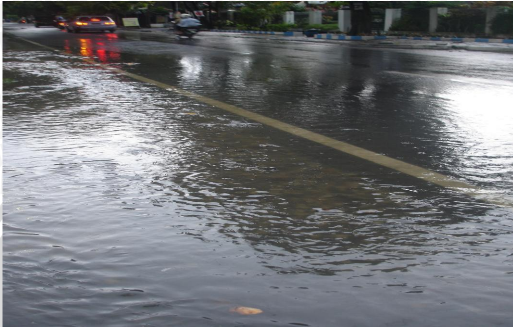
Gambar 4.30. Limpasan yang terjadi di Jl. Danau Sentani Raya (1) Sumber: Hasil survey
