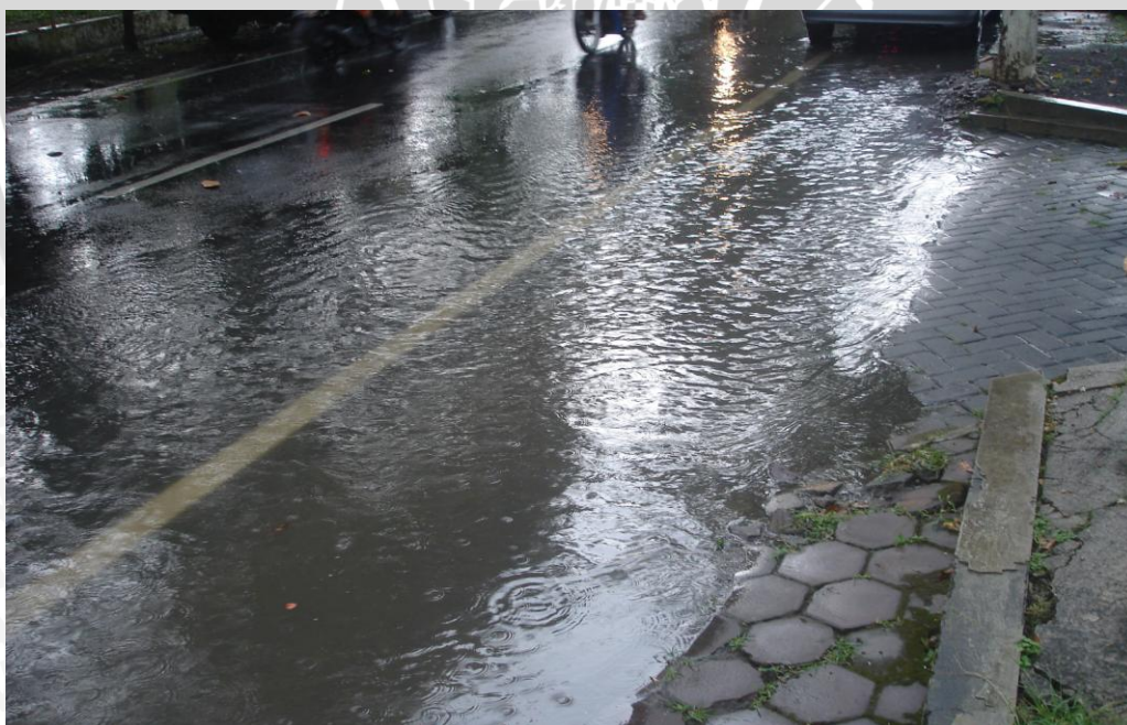
Gambar 4.31. Limpasan yang terjadi di Jl. Danau Sentani Raya (2) Sumber: Hasil survey
