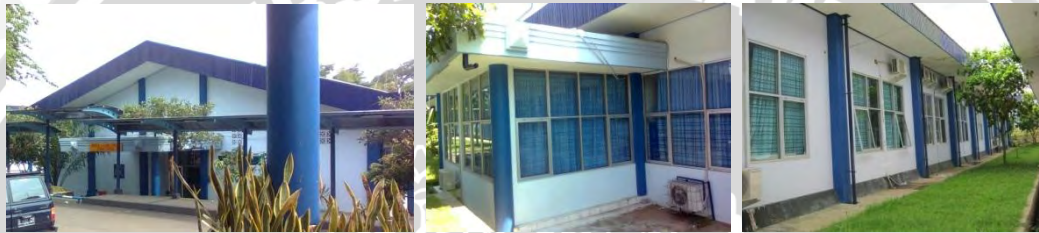
Gambar 4.55. Eksterior Bengkel dan Laboratorium Teknik Listrik
