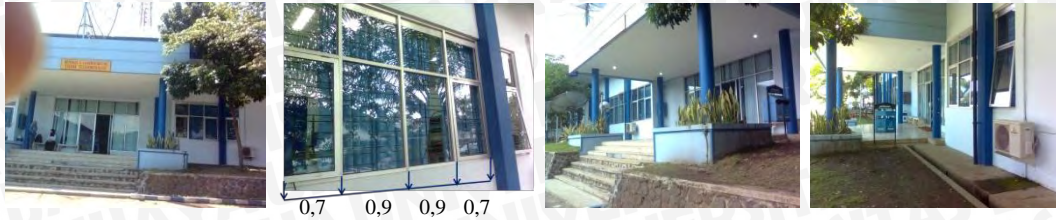
Gambar 4.23. Eksterior Bengkel dan Laboratorium Teknik Telekomunikasi Sumber: Dokumen Pribadi
