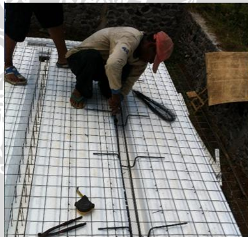
Gambar 4.10 Pemasangan Tulangan dan Pengaku
