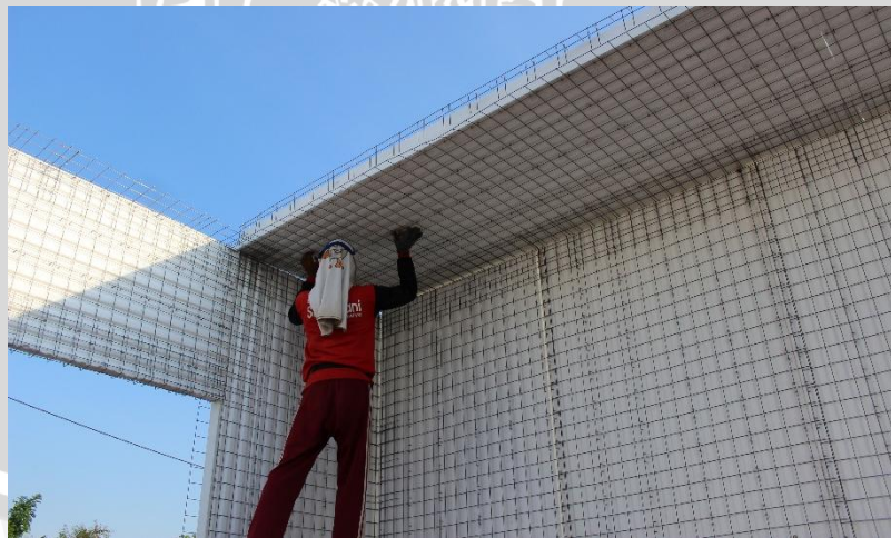
Gambar 4.6 Pemasangan Panel Pelat Lantai M-PANEL
