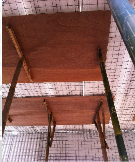
Gambar 4.9 Pemasangan Bekisting
