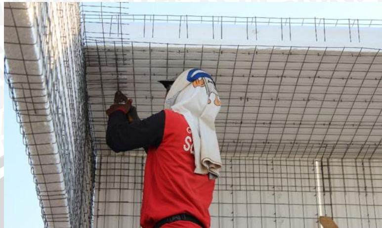
Gambar 4.7 Pemasangan Jaring Penguat Sudut
