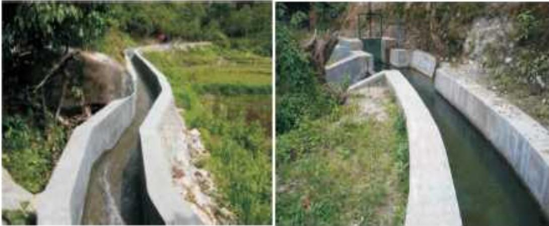
Gambar 2.9 Konstruksi Saluran Pembawa (*Headrace Channel*)
