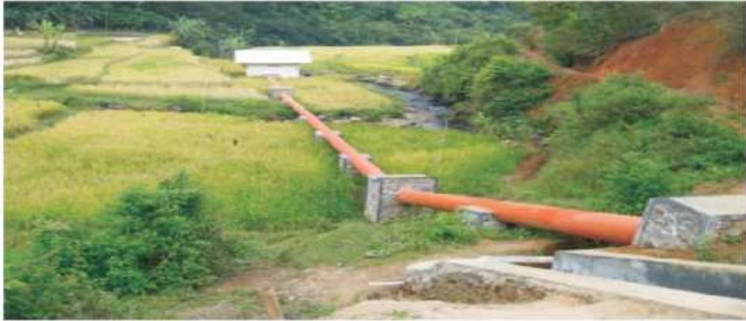
Gambar 2.11 Pipa Pesat (*Penstock*)
