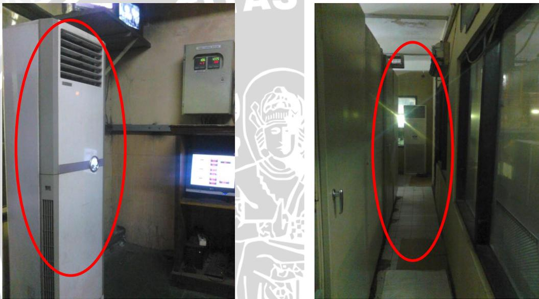
Gambar 4.7 Penempatan AC pada Panel *Boiler* dan Panel ASEA
