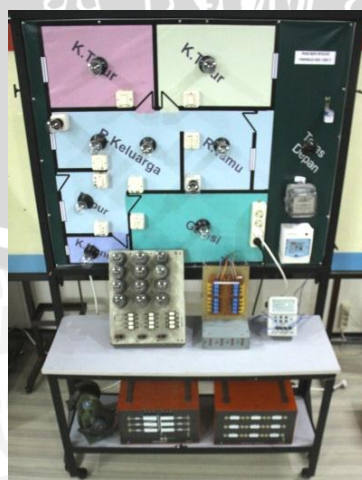
Gambar 5. 32 Rangkaian pengujian pembebanan sistem kelistrikan rumah tangga di Laboratorium Sistem Daya Elektrik TEUB
