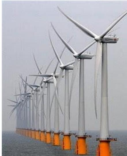
Gambar 2.5 : Turbin angin sumbu horizontal
