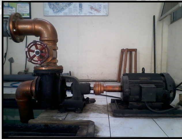
Gambar 3.1 Pompa Sentrifugal
