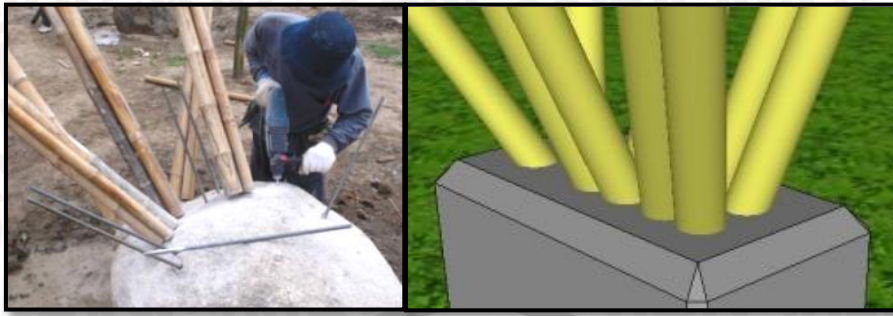
Gambar 4.43. Pondasi Tiang Pancang dengan Pedestal
