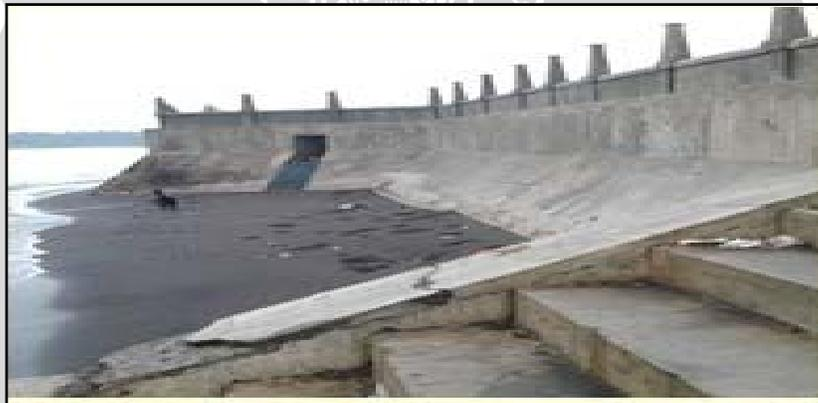
**Gambar 4.8 Pelindung Pantai Berupa Plengsengan Di Pantai Blimbingsari**
