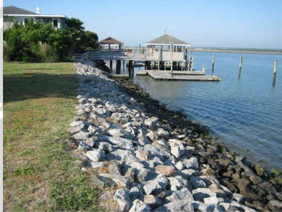
**Gambar 4.51** Perlindungan Pantai dengan *Revelment*
