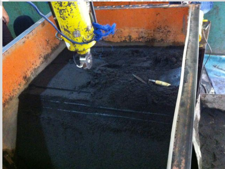
Kenampakan perkuatan geotekstil pada lereng
