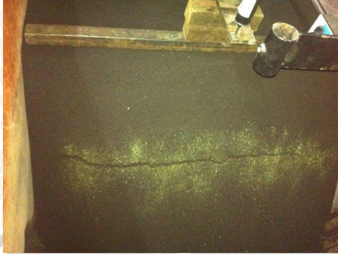
Kenampakan runtuh pada lereng
