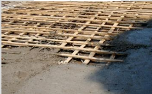
Gambar 4.11 Pelat lantai konstruksi bambu-beton komposit
