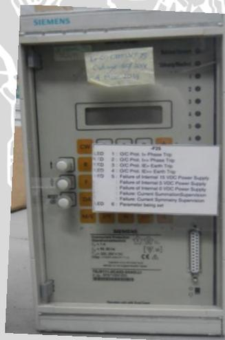
Gambar 4.5 Rele Proteksi Hubung Singkat pada Pembangkit Unit 5 dan 6 di PT. YTL
