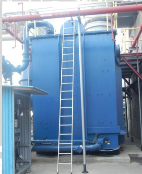
Gambar 4.1 Transformator 3 Fasa 21 kV/512,5 kV pada Pembangkit Unit 5 dan 6 di PT. YTL (Sumber: PT. YTL)
