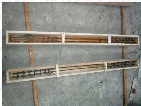
Gambar Bekisting dan Tulangan Balok
