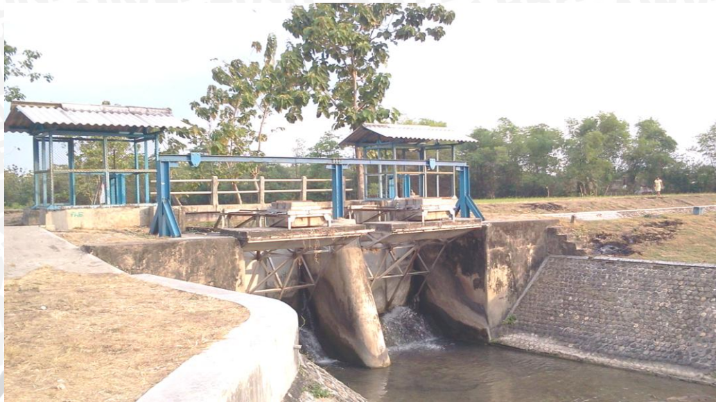
Gambar 3.3 Bendung Pirang di Desa Jatiblimbing, Kec. Dander, Kab. Bojonegoro Sumber: Dokumentasi Hasil Survei
