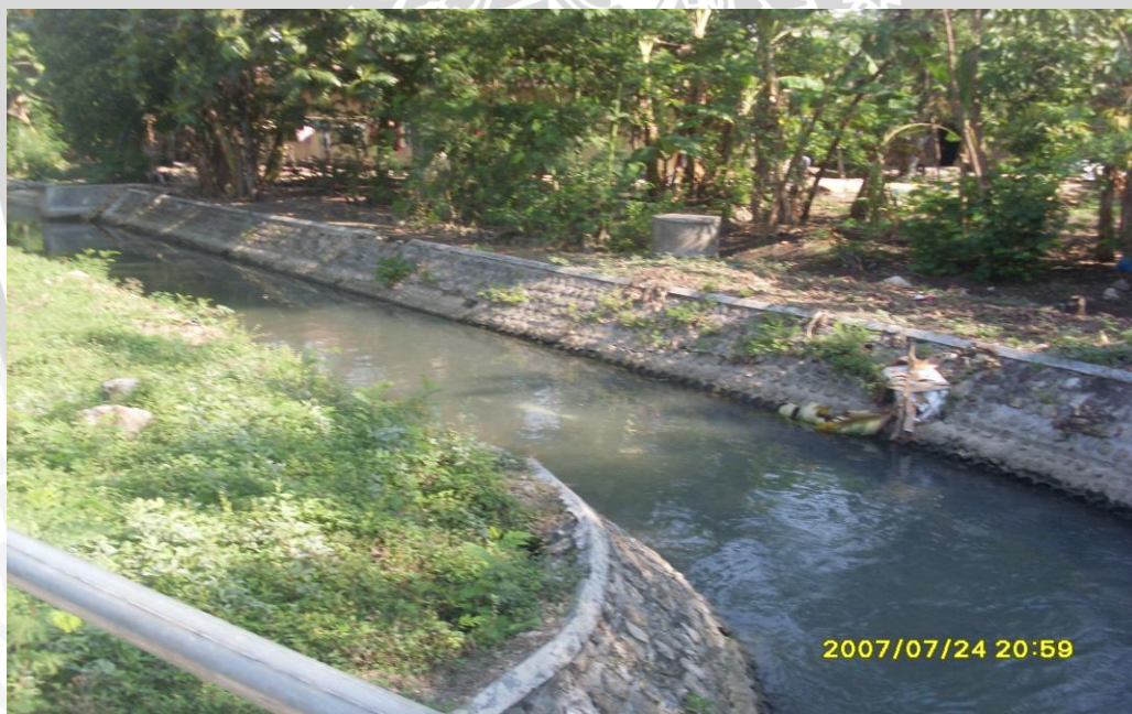
Gambar 3.8 Saluran Sekunder Pirang Kanan Sumber: Dokumentasi Hasil Survei
