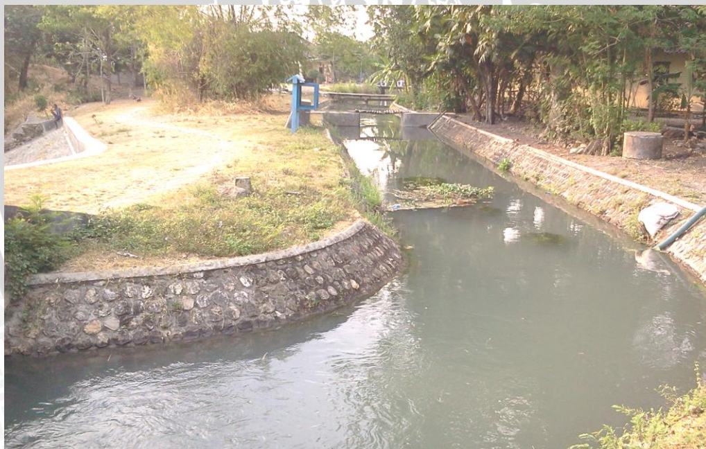
Gambar 3.4 Saluran Sekunder Pirang Kanan Sumber: Dokumentasi Hasil Survei
