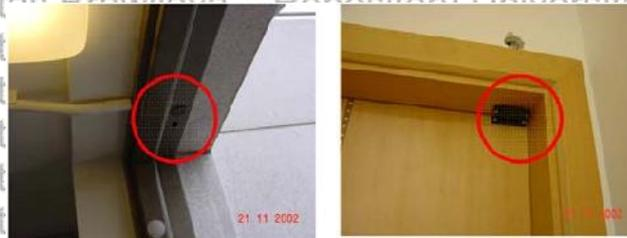
Gambar 2.93 Contoh *Magnetic Switches* (tersembunyi, kiri), (terlihat, kanan)
