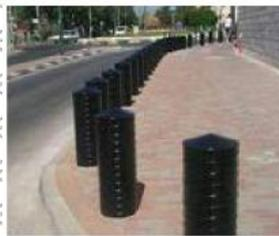
Gambar 2.16 Penerapan Penghalang berupa *bollard* terbuat dari Besi berisi Beton
