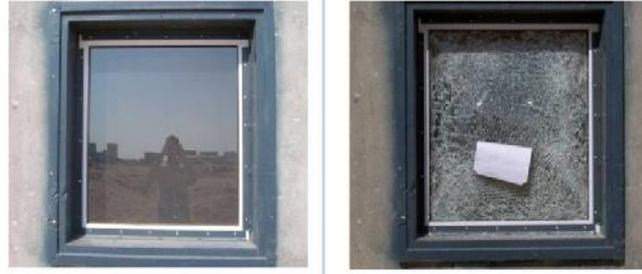
Gambar 2.77 Dampak Sistem Angkooor anti-shatter-film pada Jendela
