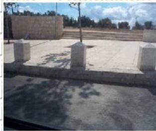
Gambar 2.15 Penerapan Penghalang berupa *bollard* terbuat dari Batu
