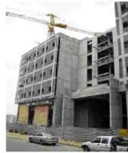
Gambar 2.67 Contoh Konstruksi Dinding Pemikul dan Penerapannya
