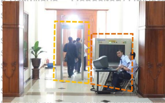
Gambar 2.116 Walk Through Screening (kiri), X-ray Screening (kanan)
