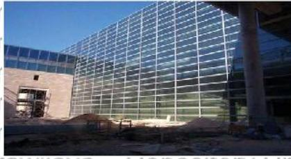
Gambar 2.71 Contoh Penerapan Selubung Bangunan Kaca secara Penuh
