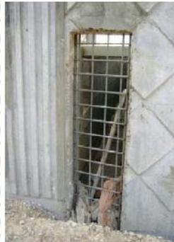
Gambar 2.99 Grill Besi pada Saluran Pembuangan
