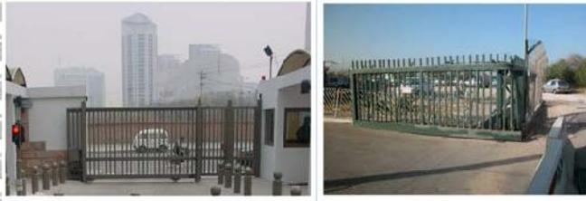
Gambar 2.33 Contoh Gerbang Anti Benturan *Sliding Gate*
