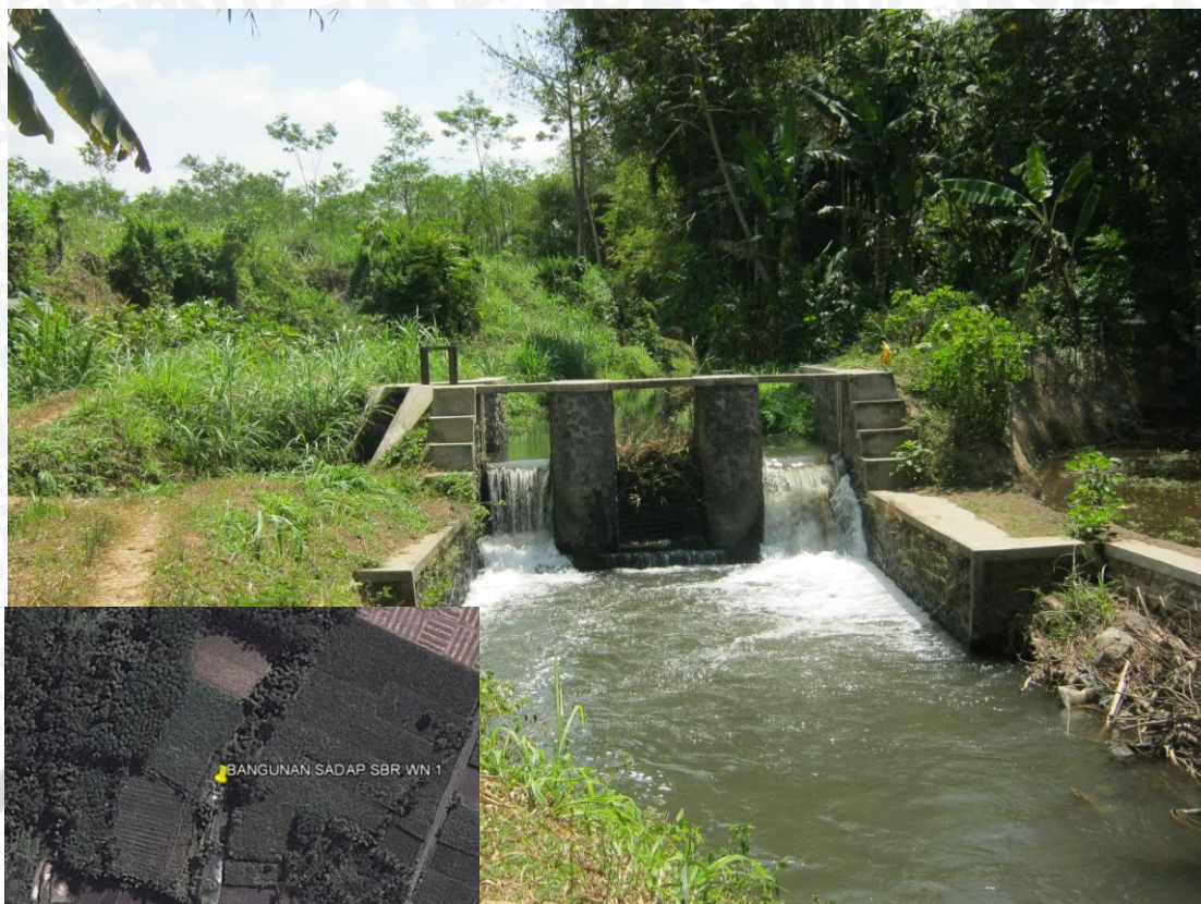
Gambar 3.8. Bangunan Sadap Sumber Wuni 1 Sumber: Dokumentasi hasil Survei (4 Oktober 2013)
