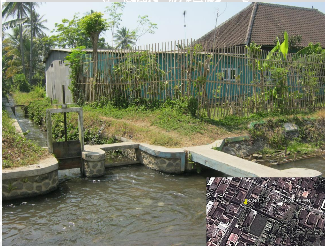
Gambar 3.9. Bangunan Sadap Sumber Wuni 2 Sumber: Dokumentasi hasil Survei (4 Oktober 2013)
