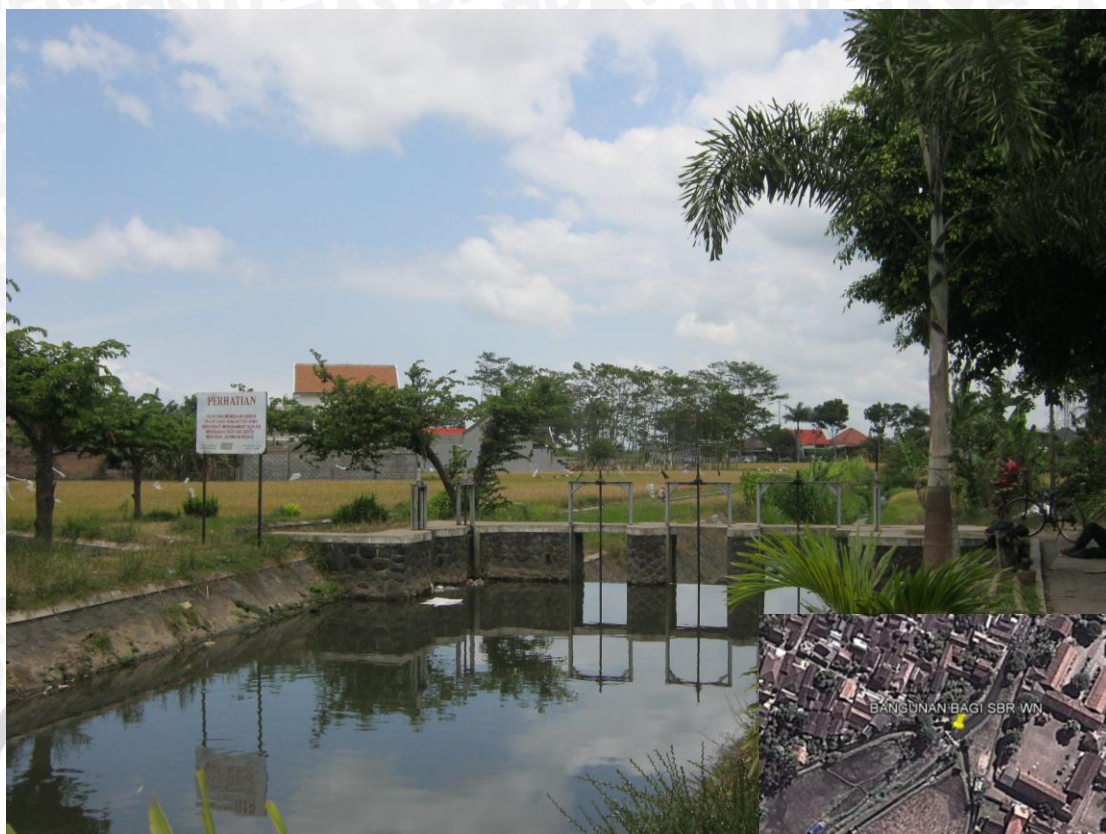
Gambar 3.10. Bangunan Bagi Sumber Wuni Sumber: Dokumentasi hasil Survei (4 Oktober 2013)
