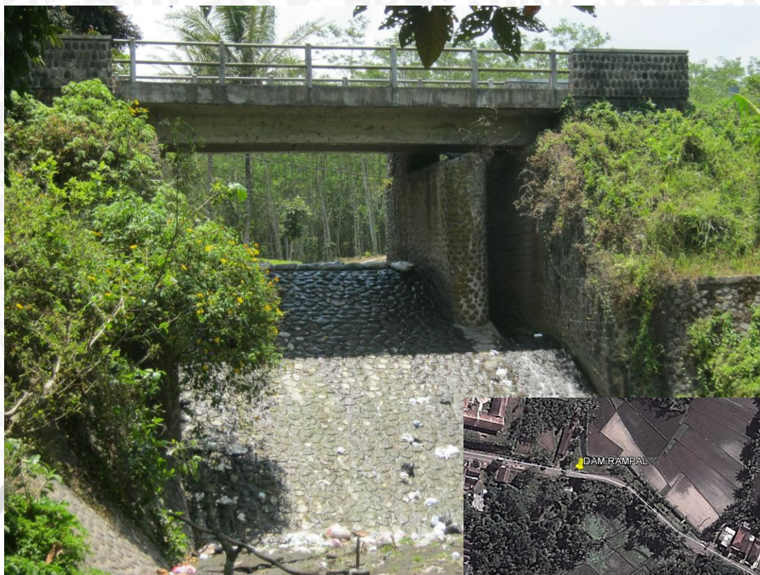
Gambar 3.4. Dam Rampil Sumber: Dokumentasi hasil Survei (4 Oktober 2013)
