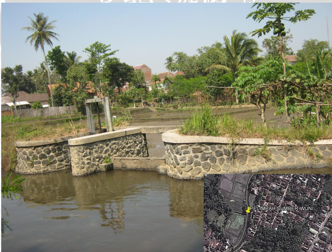
Gambar 3.7. Spillout DI Sumber Wuni Sumber: Dokumentasi hasil Survei (4 Oktober 2013)
