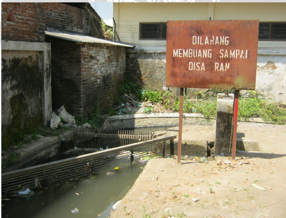
Gambar 3.13. Inlet Saluran Air Industri PT. PINDAD Persero Sumber: Dokumentasi hasil Survei (4 Oktober 2013)
