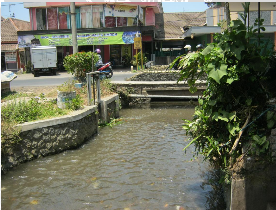
Gambar 3.11. Bangunan Sadap Sumber Wuni 3 Sumber: Dokumentasi hasil Survei (4 Oktober 2013)
