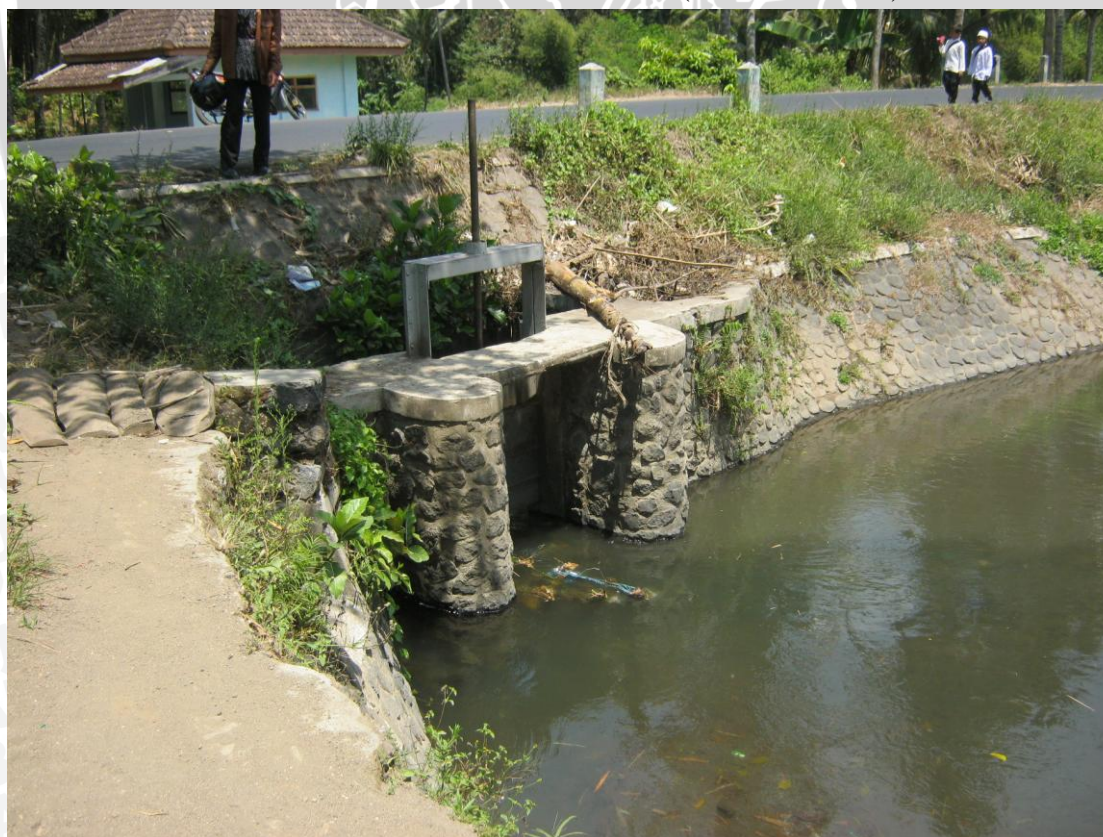
Gambar 3.5. Intake Dam Rampil Sumber: Dokumentasi hasil Survei (4 Oktober 2013)
