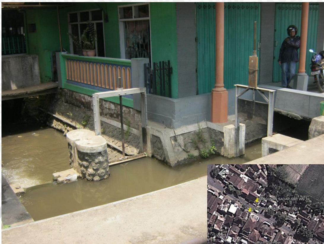
Gambar 3.12. Bangunan Sadap Sumber Wuni 4 Sumber: Dokumentasi hasil Survei (4 Oktober 2013)
