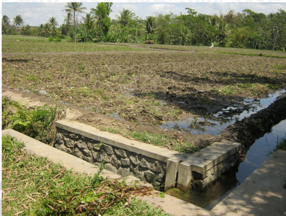
Gambar 3.16. Saluran Tersier Sumber Wuni 1 Kanan Sumber: Dokumentasi hasil Survei (4 Oktober 2013)
