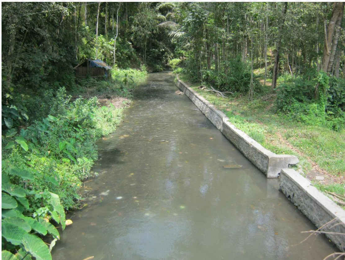
Gambar 3.6. Kantong Lumpur DI Sumber Wuni Sumber: Dokumentasi hasil Survei (4 Oktober 2013)
