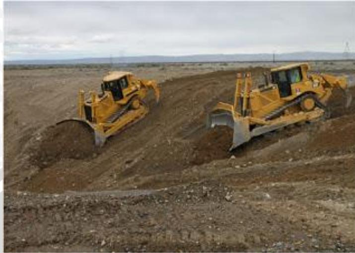
**Gambar 4. 11 Pemindahan tanah (*back filling*)**
