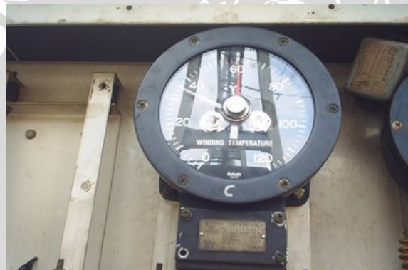
Gambar 2.9 Indikator Pada Transformator
