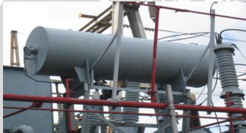
Gambar 2.6 Tangki-Konservator Transformator
