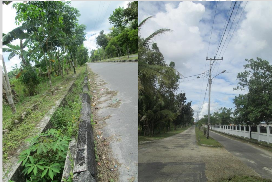
Gambar 4.7 Kondisi Jaringan Drainase dan Jaringan Listrik
