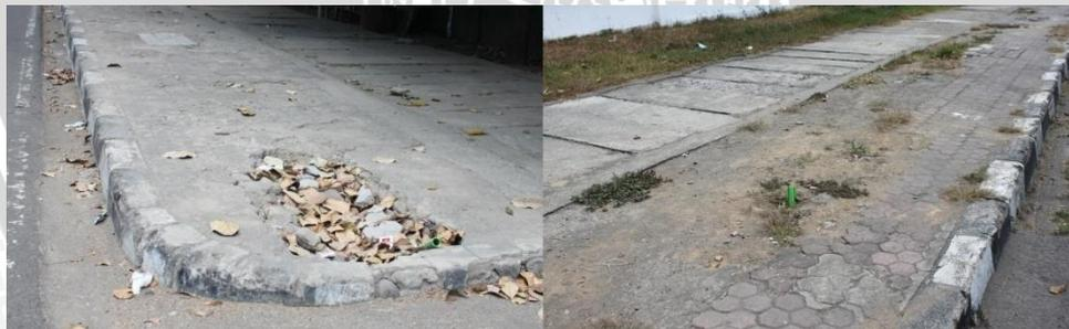
**Gambar 4. 11 Kondisi perkerasan trotoar pada segmen 2**
