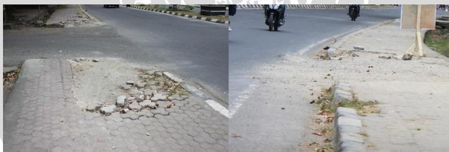
**Gambar 4. 9 Kondisi perkerasan trotoar pada segmen 1**
