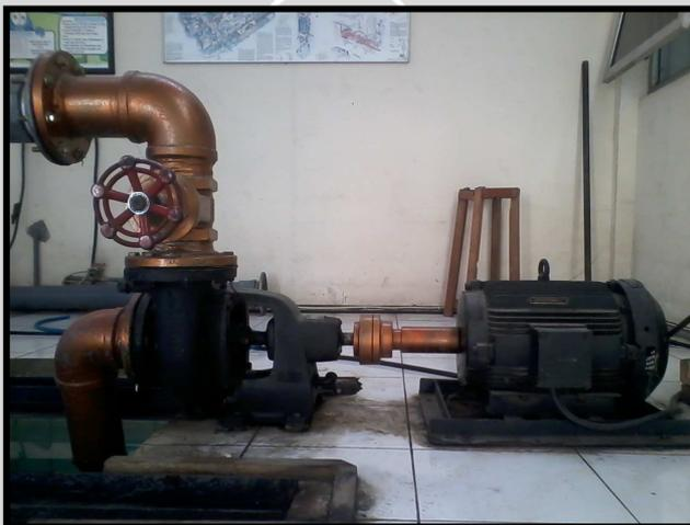
Gambar 3.1 Pompa Sentrifugal
