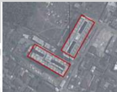
Gambar 1.1 Eksisting rumah susun kedungkandang Malang
