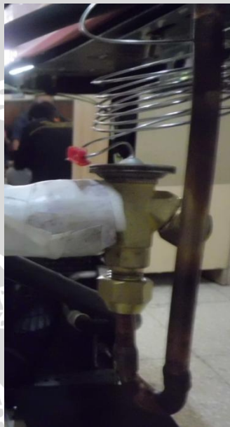
Gambar 2.7 Katup ekspansi
