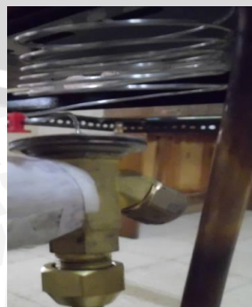
Gambar 3.4 Katup ekspansi
