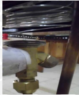
Gambar 3.4 Katup ekspansi
