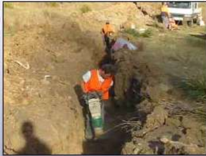
Gambar 2.15. Contoh upaya pemadatan tanah dispersif. Sumber : Hardie, 2009b
