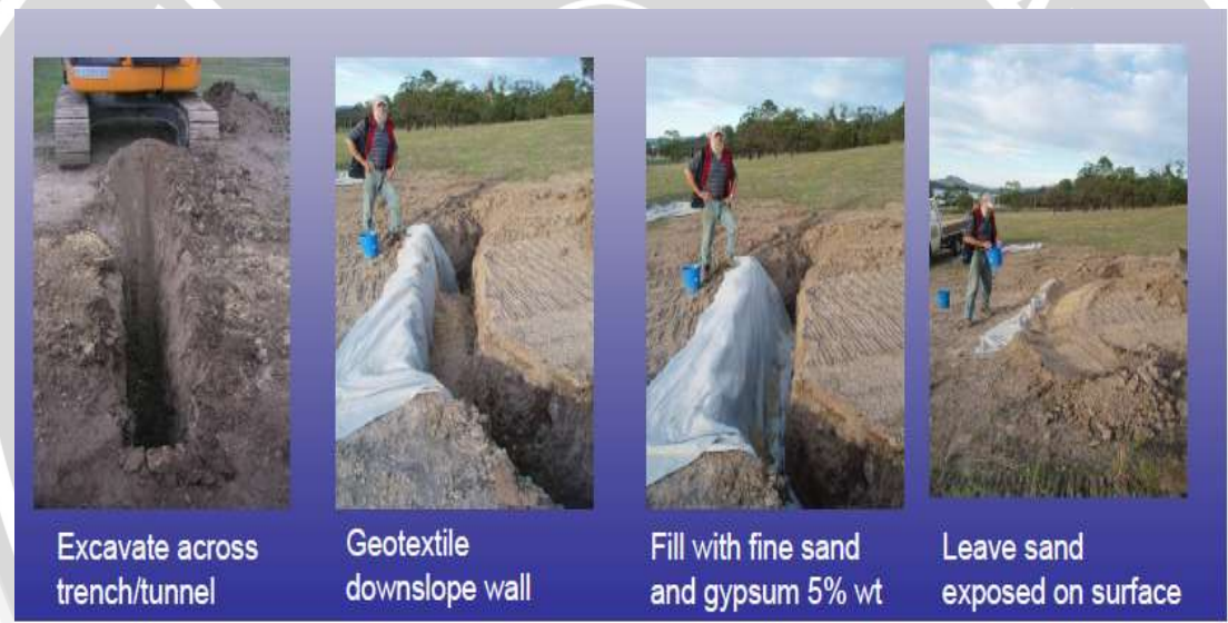
Gambar 2.17. Pemasangan sandblock, Sumber : Hardie, 2009b
