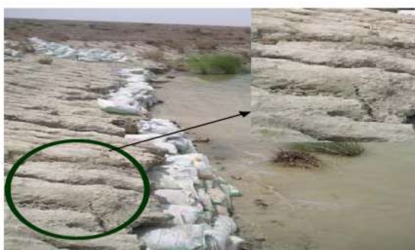
Gambar 2.3. Erosi pada tanggul akibat tanah dispersif Sumber : Bhuvaneshwari, S. and Soundara, B., 2007
