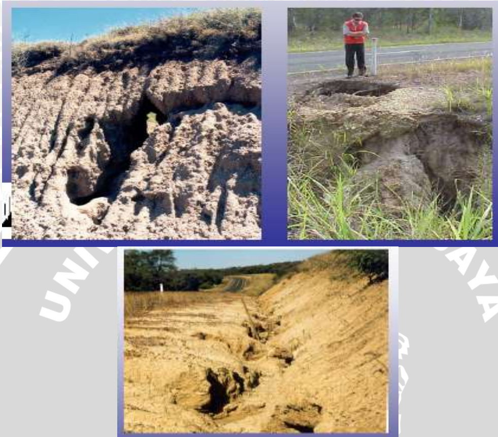
Gambar 2.4. Longsor pada tebing akibat tanah dispersif. Sumber : Hardie, 2009a
