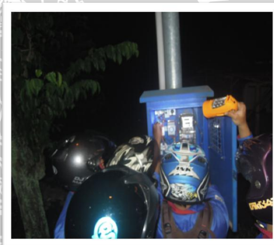
Pengukuran arus, tegangan, daya, dan \cos \phi
