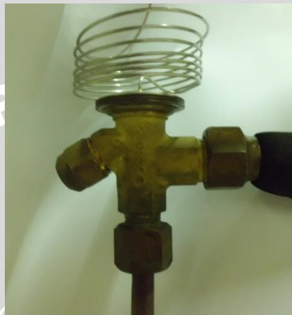
Gambar 2.8 Alat ekspansi
