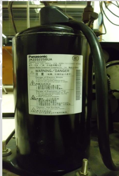
Gambar 2.5. Kompresor jenis rotari
