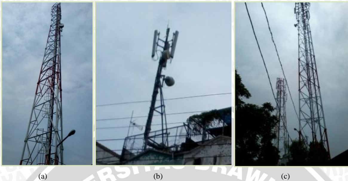
Keterangan : a) triangular tower ; b) monopole tower ; c) rectangular tower Gambar 4.21 Bentuk-bentuk menara berdasarkan penompang antena BTS
