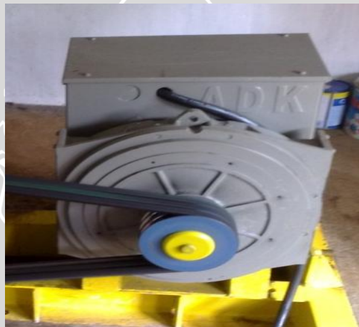
Gambar 3.2. Generator Sumber : Instalasi PLTMH Andungbiru
