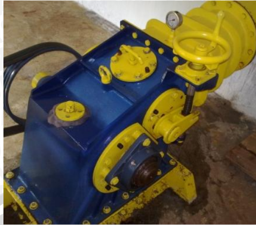
Gambar 3.1. Turbin Cross Flow Sumber : Instalasi PLTMH Andungbiru
