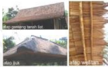
Gambar 2.10 Atap Rumah Using (Sumber: Arystianto, 2008)
