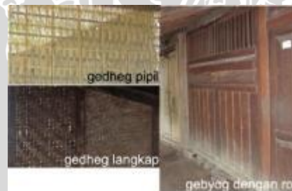
Gambar 2.11 Dinding Rumah Using (Sumber: Arystianto, 2008)
