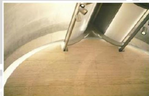
Gambar 2.31 *Baffle* pada *skylight*
