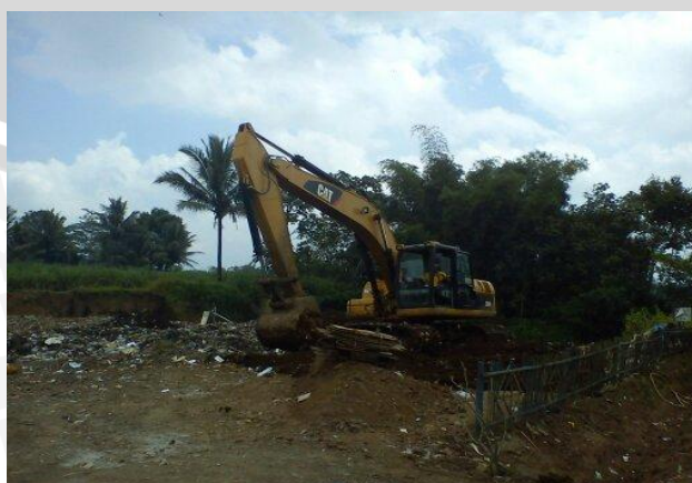
Gambar 4.15 Proses perataan dan pemadatan sampah dengan sistem controlled landfill
