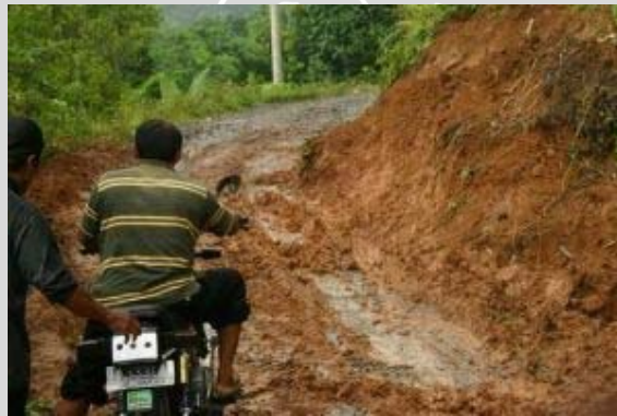
Gambar 3.4 Longsor Di Desa Gumeng Sumber: Survey
