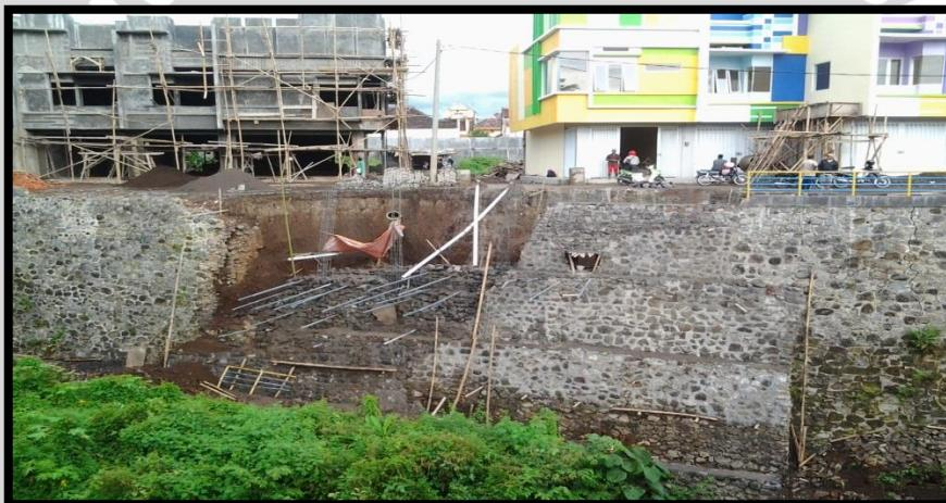
**Gambar 1.1** Longsor dinding penahan pada lereng bangunan ruko
