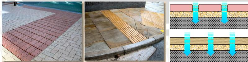
**Gambar 2.12. Paving tactile untuk memfasilitasi para difabel, paving concrete (atas) dan paving porous (bawah)**
