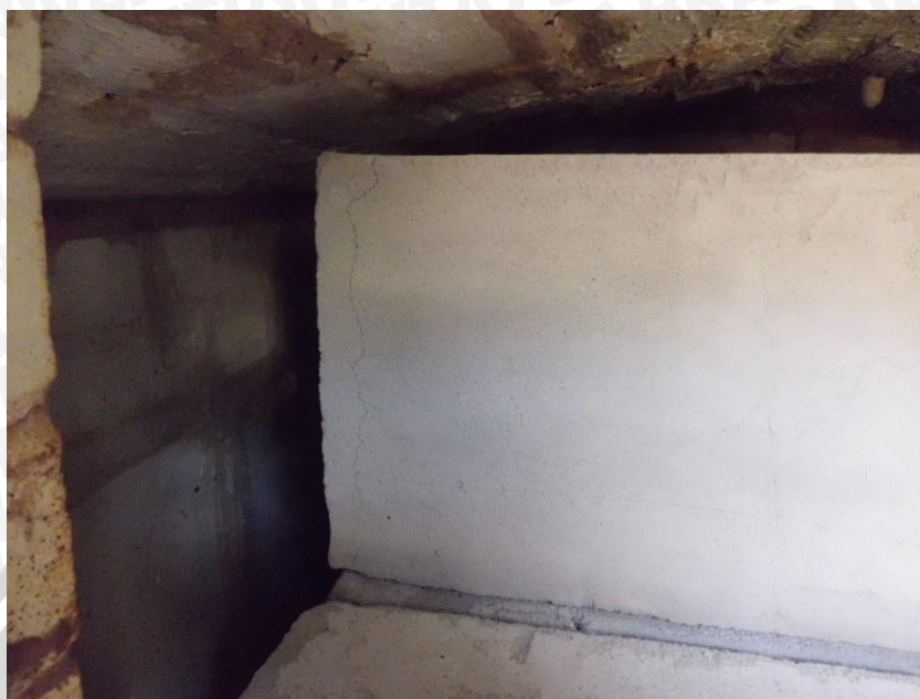
Gambar. Kondisi benda Uji Setelah mengalami Proses Pembakaran pada Suhu 800°C, Terjadi retak rambut pada sisi benda uji
