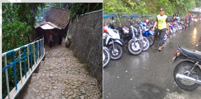
Gambar 4. 4 Kondisi Jalan dan Area Parkir Lokasi Air Terjun Sedudo
