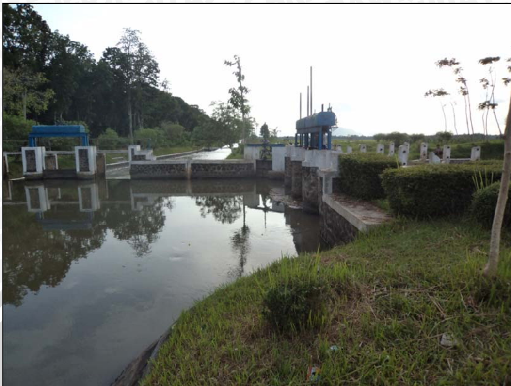
Gambar 3. 6 Intake Menuju Saluran Primer Wonojati dan Saluran Primer Mayang Sumber : Dokumentasi Hasil Survei
