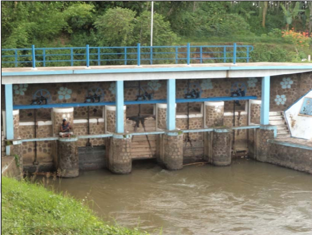
Gambar 3. 4 Intake Saluran Induk dari Bendung Talang Sumber : Dokumentasi Hasil Survei
