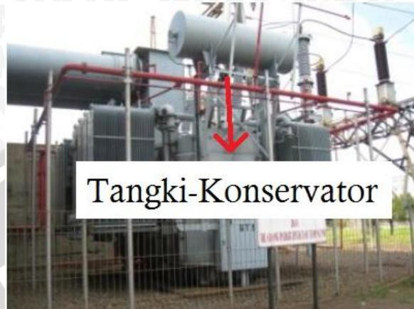
Gambar 2.6 Tangki-Konservator Transformator
