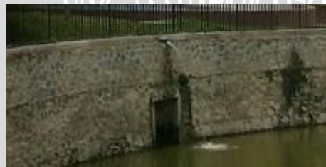
Gambar 4.24 Pipa Saluran Air dari Kolam Renang menuju Kolam Perahu
