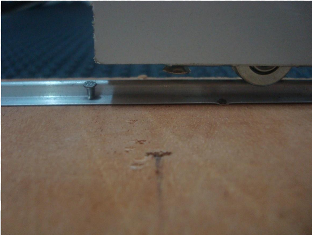
Gambar 1 Pembuatan roda dan lintasan pintu pagar
