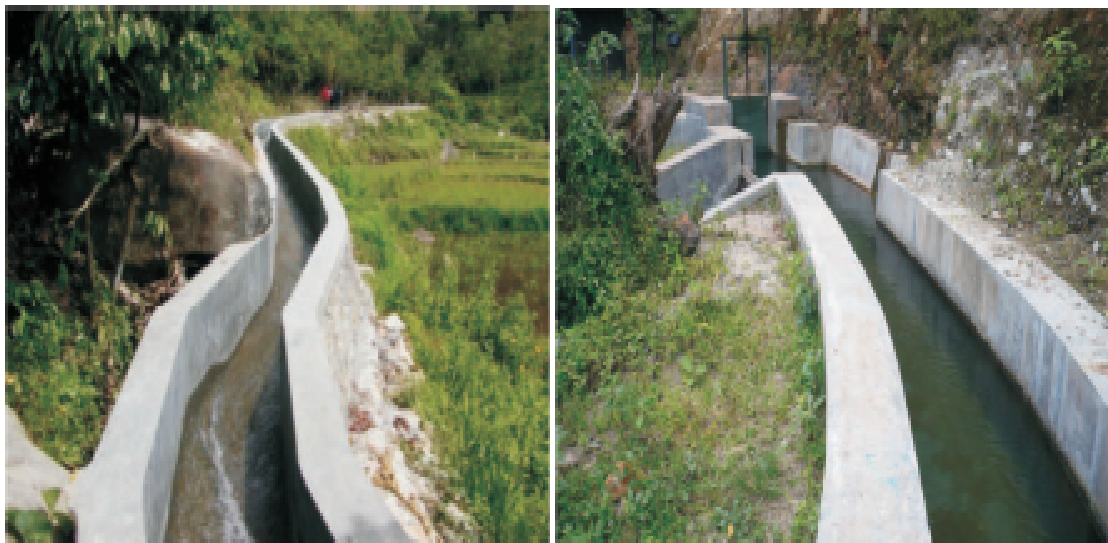
Gambar 2.14 Konstruksi Saluran Pembawa ( Headrace Channel )
